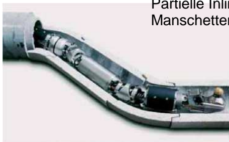
Reparatur: Roboter mit Fräskopf
