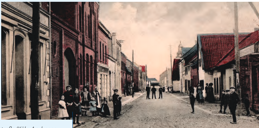
Die Hauptstraße (Köln-Aachener Straße) in Elsdorf um die Jahrhundertwende; Ansichtskarte (Ausschnitt), Stadtarchiv Elsdorf
